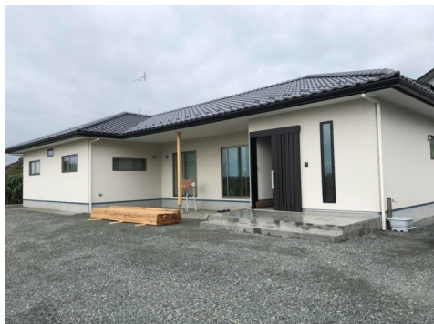
新築現場の施工事例
