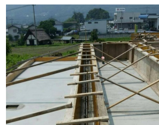
《 施工事例③ 》
