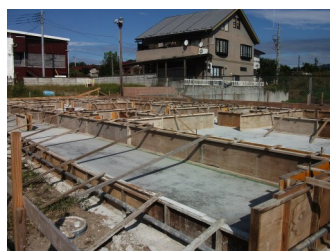
《 施工事例① 》
